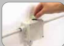
**10.v** Chiudere il foro impiegato per la colata con il tappo in dotazione; installazione terminata. Attendere la reticolazione completa del prodotto prima di un'eventuale apertura della cassetta.
