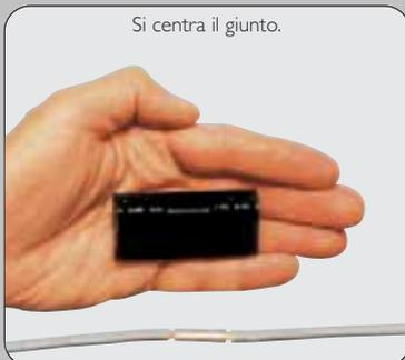
Si chiude il giunto e si controlla che il gel sia fuoriuscito. Giunto terminato e pronto a essere energizzato.
